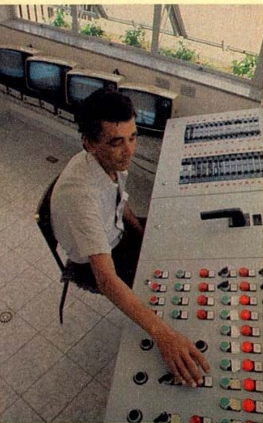
O superpainel do Edifício Pinati: o controle das seis câmaras que focalizam o exterior e transmitem as imagens para os apartamentos
